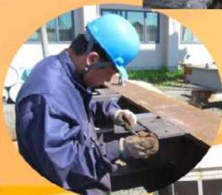
↑ 鉄板を鉄骨に ボルトで固定 →
